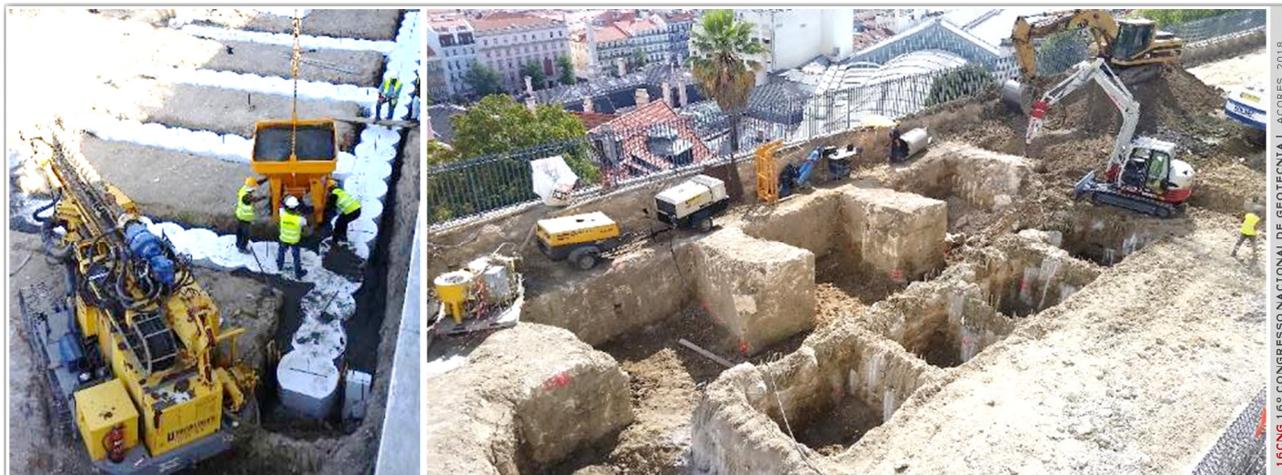
Figura 9 – Vista dos trabalhos de execução do muro guia e vista dos contrafortes do muro inferior
