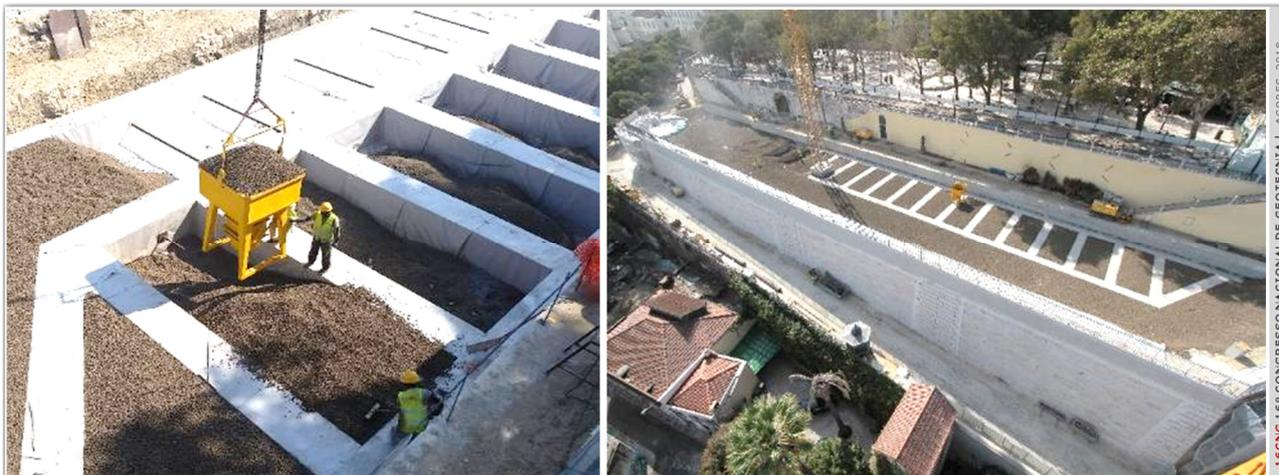
Figura 11 – Vista da aplicação da primeira camada de aterro de agregados leves
